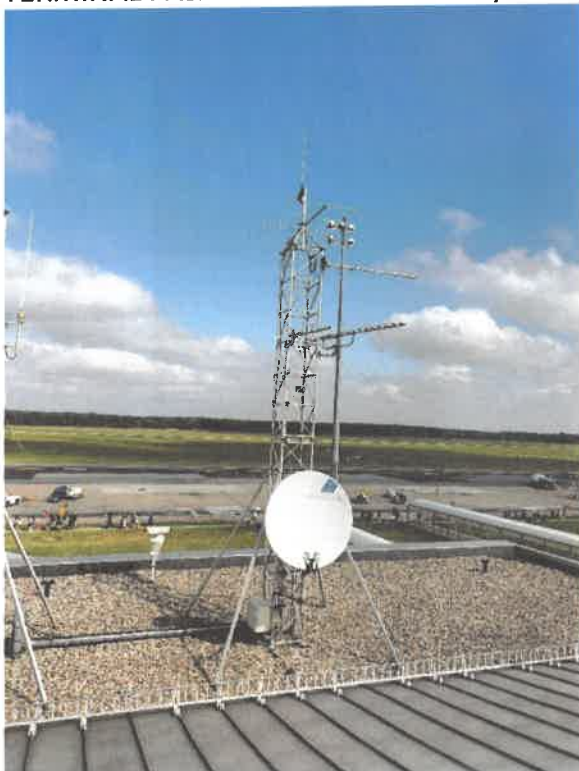
TERMINAL PASAZERSKI BUD NR 1 – wysokość ok. 7-8,0 m
