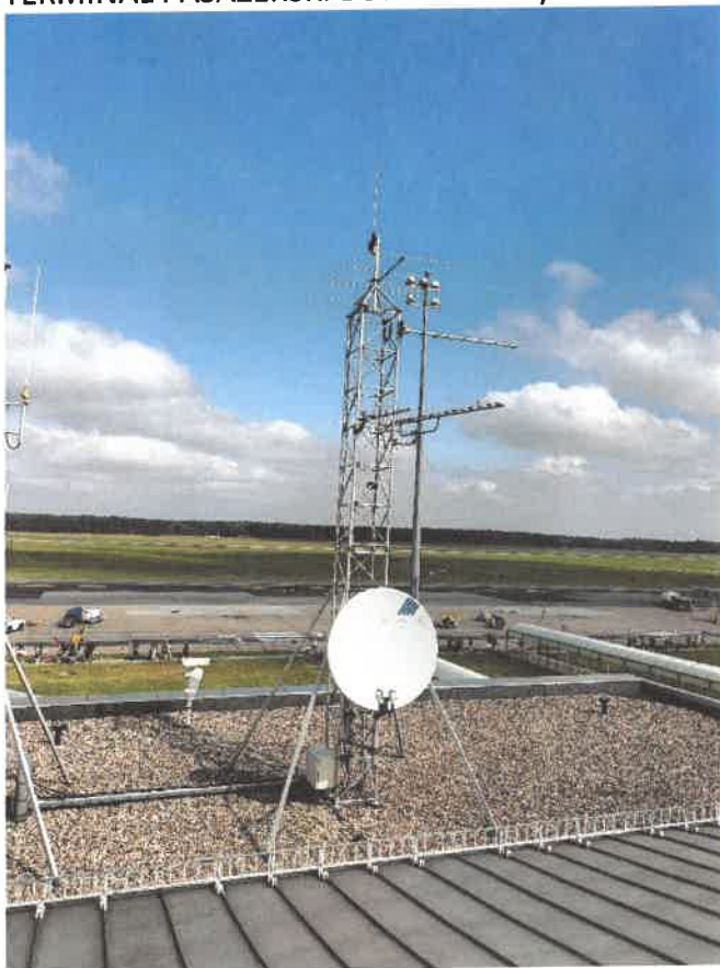
TERMINAL PASAZERSKI BUD NR 1 – wysokość ok. 7-8,0 m
